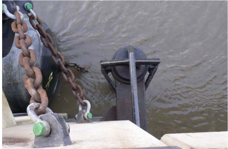
Abb. 13: Gesicherter Pfahlkopf (Draufsicht)
