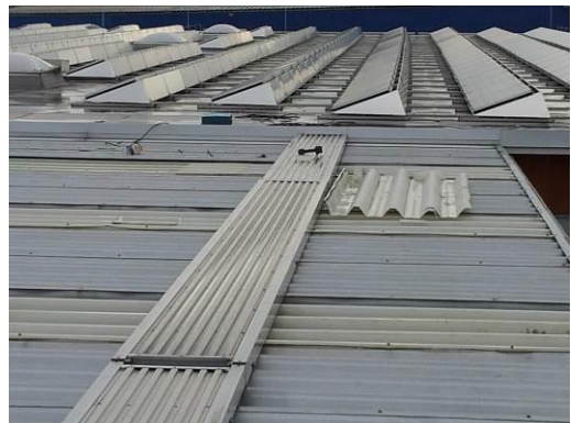
Abb. 10: Wartungssteg auf Hallendach
