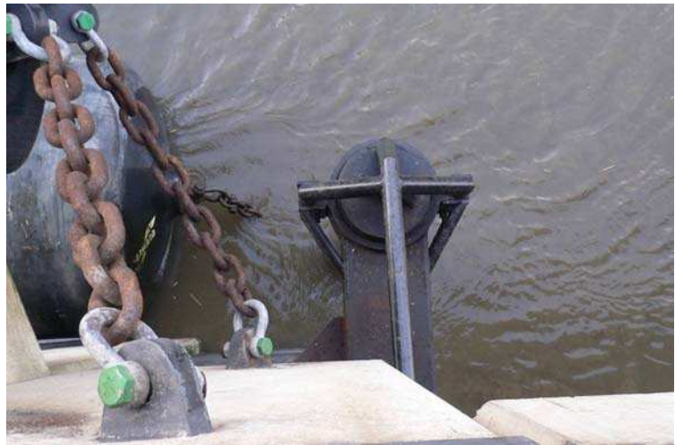
Abb. 13: Gesicherter Pfahlkopf (Draufsicht)
