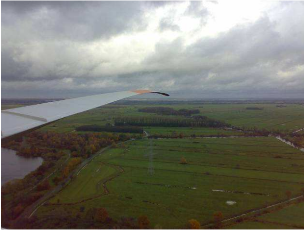
Abb. 26: Standort Windkraftanlage im Umland von Bremen
