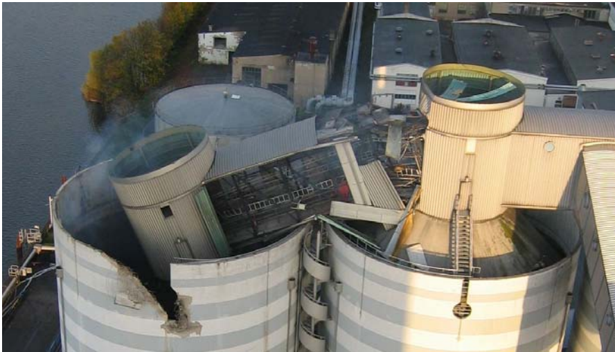
Abb. 51: Silo 4 nach der Explosion
