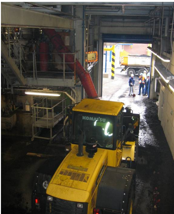
Abb. 52: Entleeren der Zuteiler/Tagesbunker
