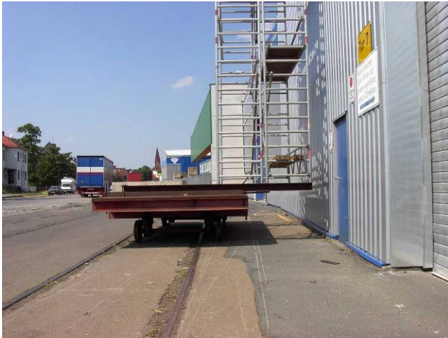
Abb. 23: Eine eigenwillige Konstruktion aus Schienenfahrzeug, Doppel T-Trägern und Gerüst
