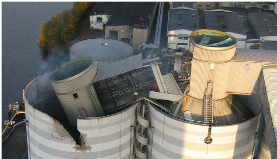
Abb. 51: Silo 4 nach der Explosion
