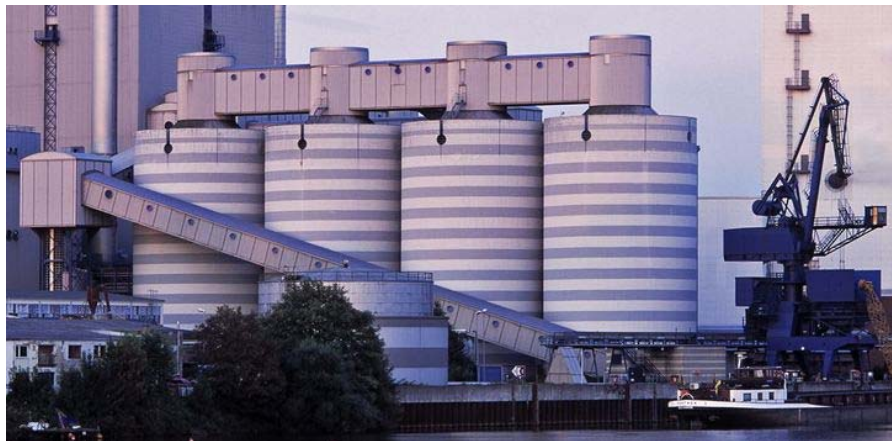
Abb. 50: Bild der Bekohlung - Silo 1 bis 4 von links nach rechts-
