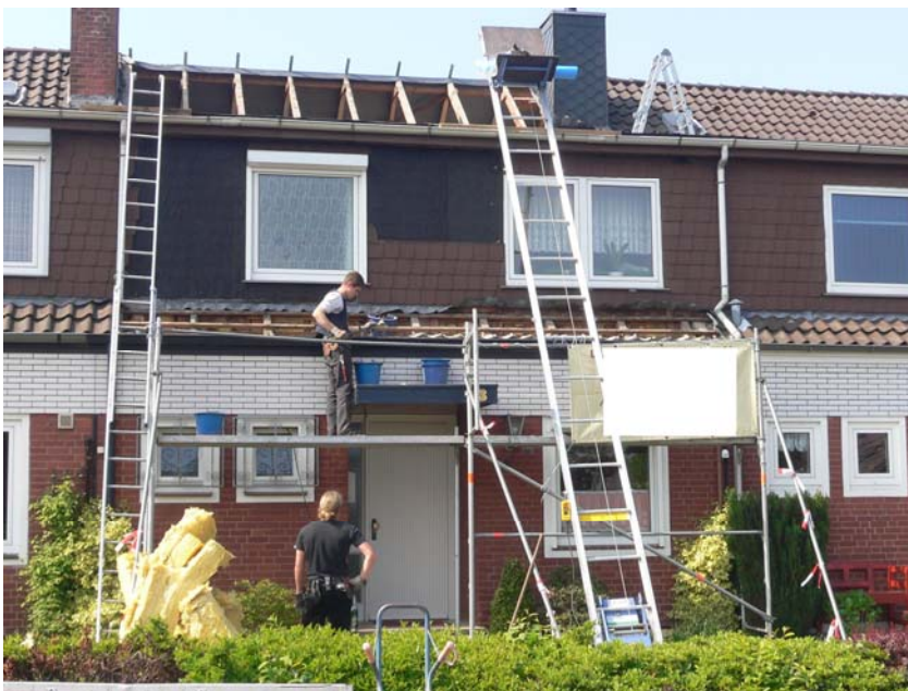
Abb. 21: Bauarbeiten zum Zeitpunkt der Besichtigung
