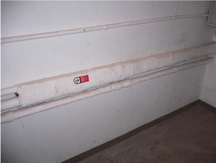
Abb. 19: Asbestrohrleitung
