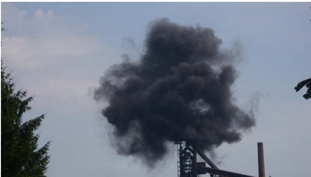
Abb. 34: Typische Wolken aus Gichtstaub beim Öffnen der Bleeder
