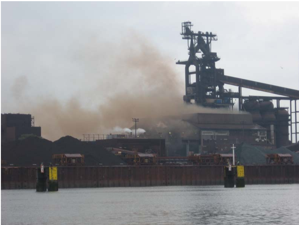
Abb. 33: Typische diffuse Staubentwicklung beim Abstich am Hochofen II
