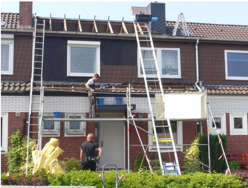
Abb. 21: Bauarbeiten zum Zeitpunkt der Besichtigung
