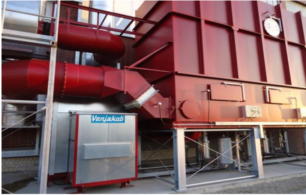
Abb. 26: Drei-Kammer-Wärmetauscher
