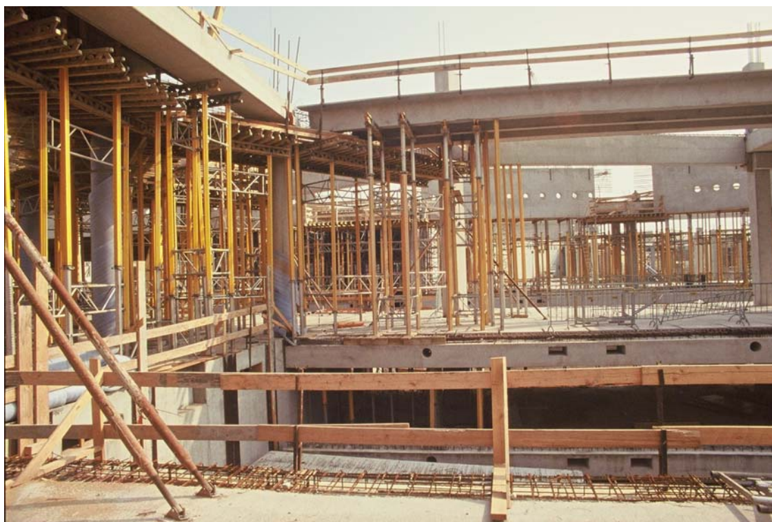
Bild: Deckenkonstruktion bei der Baustelle Space Park
