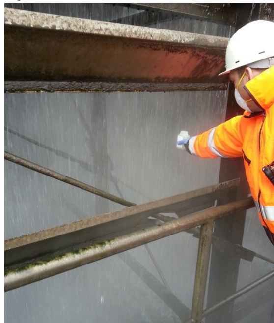
Foto: Probenahme an einer Verrieselung
