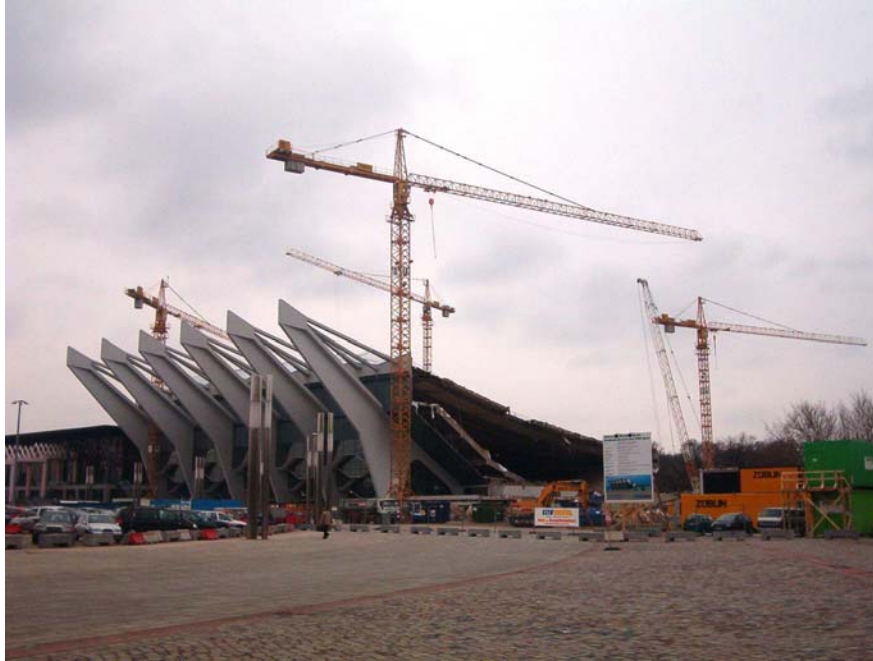
Bild 17: Zusammenarbeit von mehreren Baukränen auf einer Baustelle
