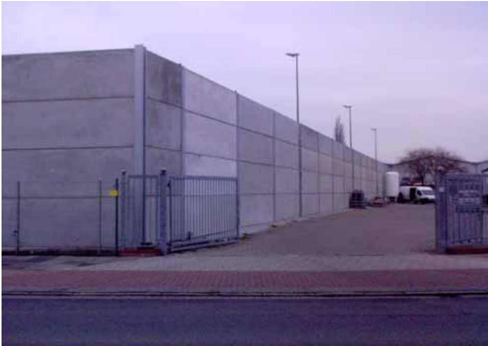
Abb. 59: Neu installierte Lärm- und Sichtschutzwand
