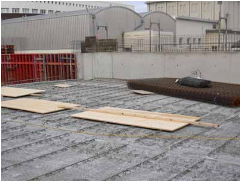
Abb. 9: Betondeckenplatte mit abgedeckter RWA-Öffnung
