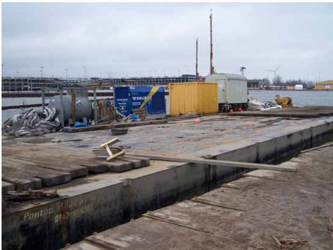
Abb. 5: Ponton mit hölzerner Baggermatratze
