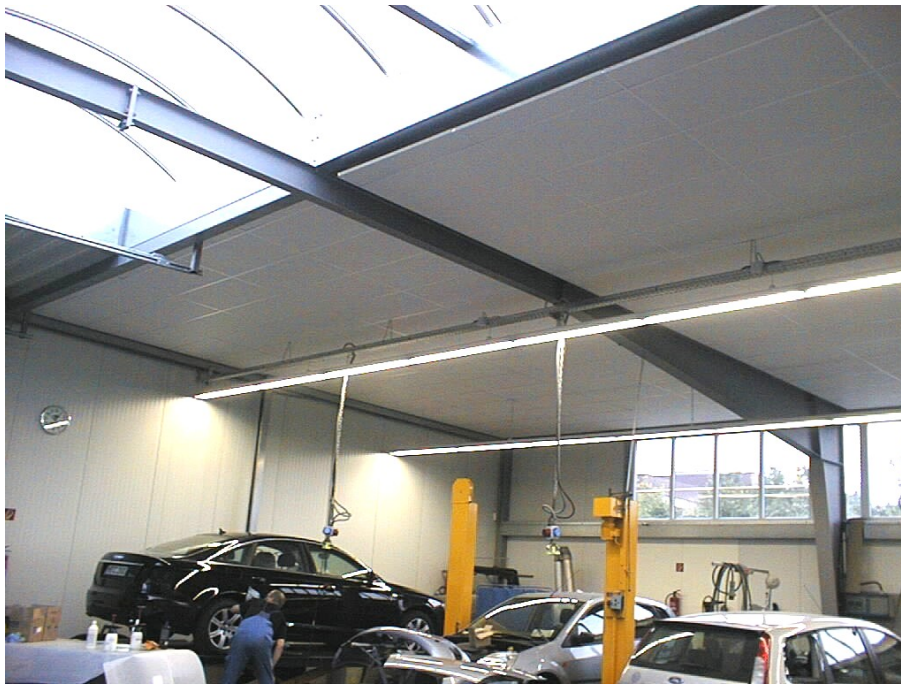
Abb. 12: Werkhalle mit Akustikdecke
