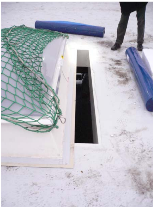
Abb. 6: Dachöffnung mit Lichtkuppel
