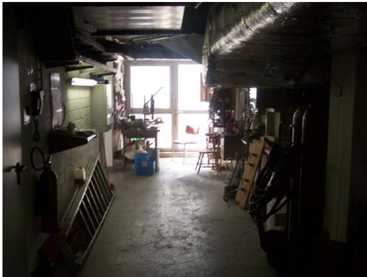
Abb. 17: Fluchtweg in den Technikräumen eines Schwimmbads
