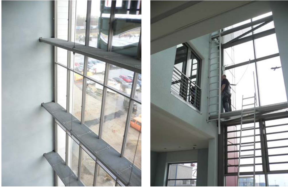
Abb. 5: Teilansicht Eingangshalle, Glasfassade mit Putzbalkon (vorher/nachher)
