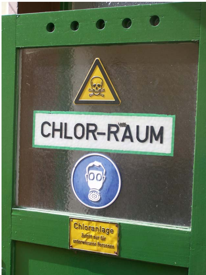
Abb. 16: Kennzeichnung des Chlorungsraumes eines Schwimmbades
