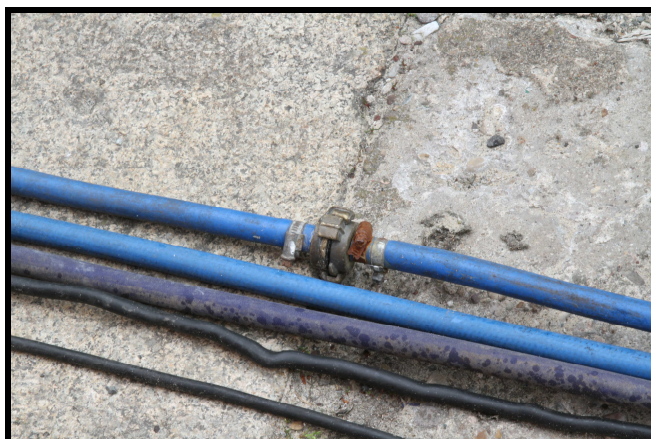
Bild 3: Ungeschützt auf dem Boden liegende Schlauchkupplung (drohender Keimeintritt).
