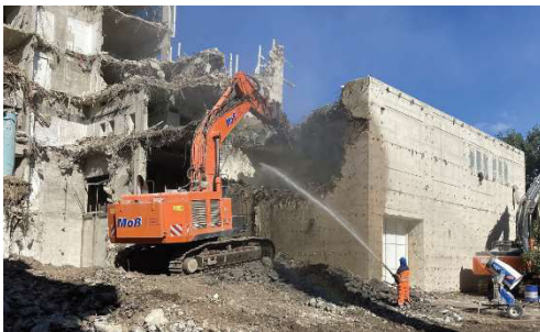
Schadstoffsanierung, Staubbindung mittels Wasser-schlauch, Staubbindung mittels Bewässerung in den noch zugänglichen Gebäudebereichen
