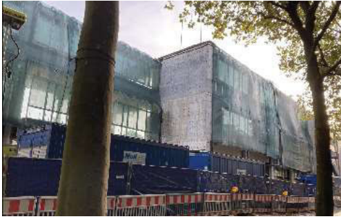
Staubbindung durch Netze an der Gebäudehalle
