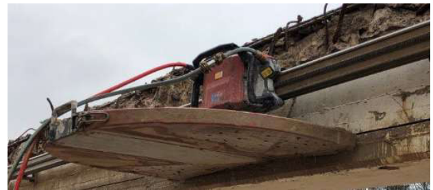
Betonsäge im Einschnitt (Quelle: Bauherr)
