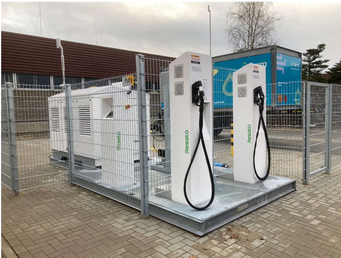
Foto der mobilen Wasserstofftankstelle für die Betankung von Wasserstoff-Bussen bei der Verkehrsgesellschaft Bremerhaven AG
